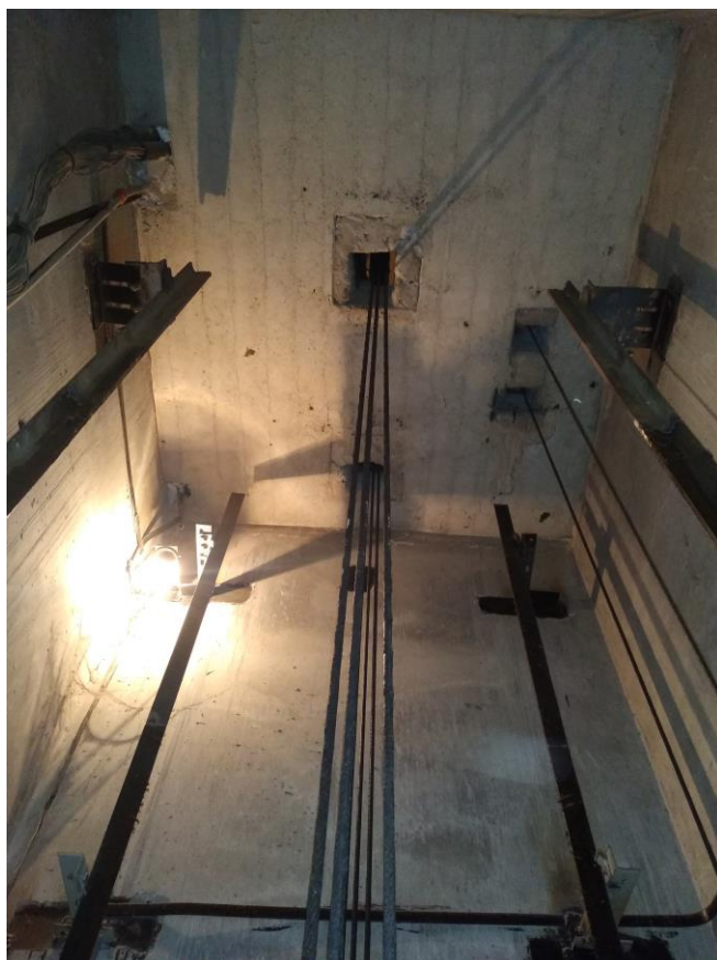
Рисунок 3 – Плита перекрытия шахты
