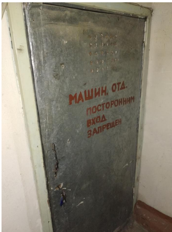
Рисунок 4 – Вход в машинное помещение
