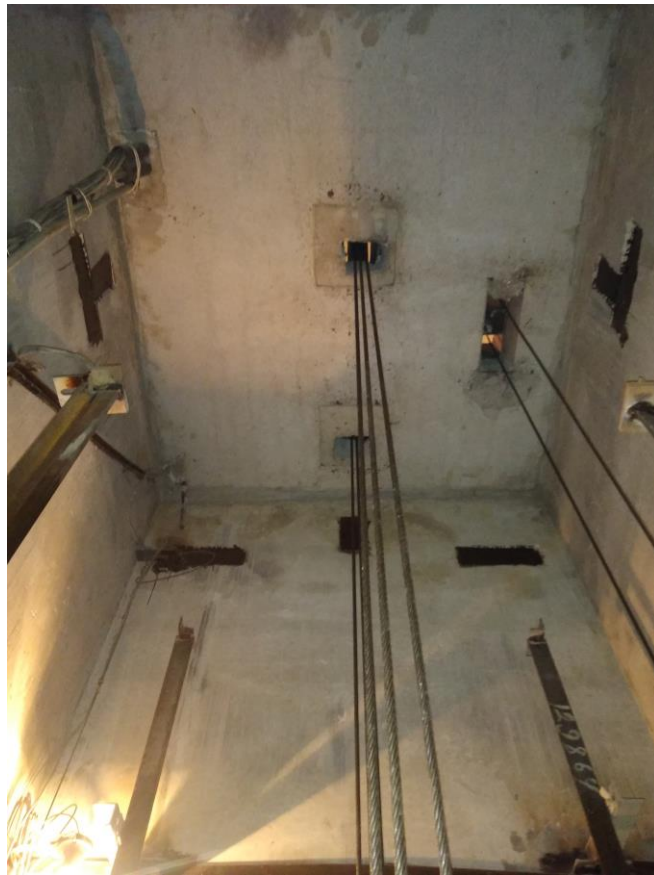
Рисунок 3 – Плита перекрытия шахты
