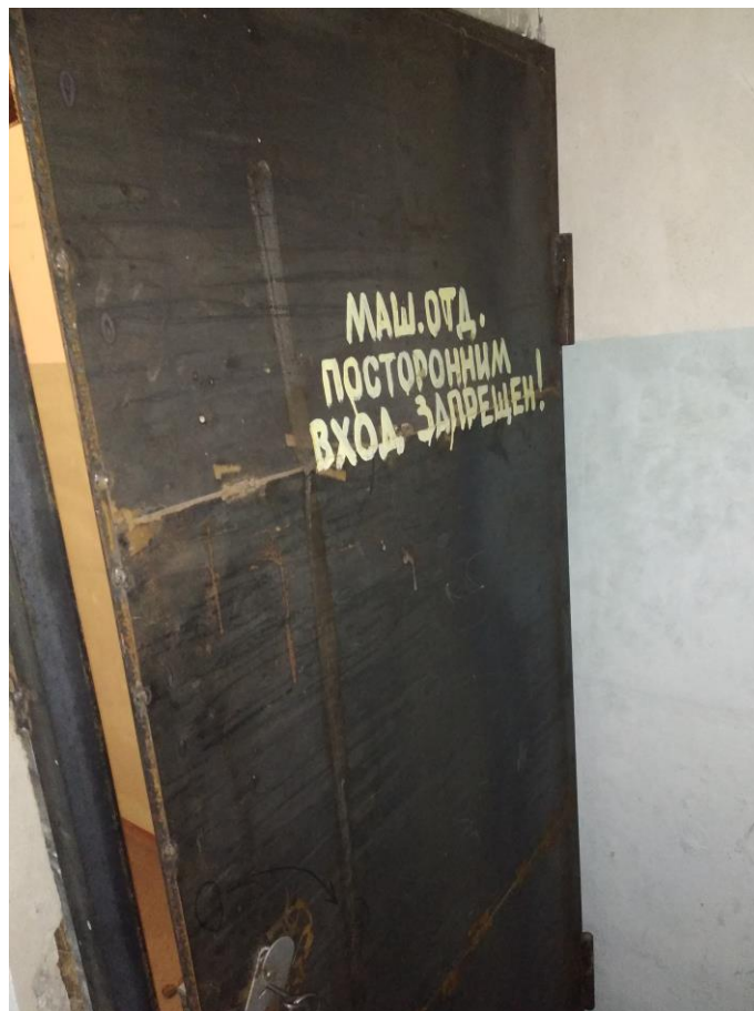
Рисунок 4 – Вход в машинное помещение
