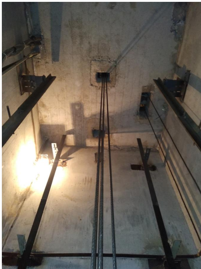
Рисунок 3 – Плита перекрытия шахты
