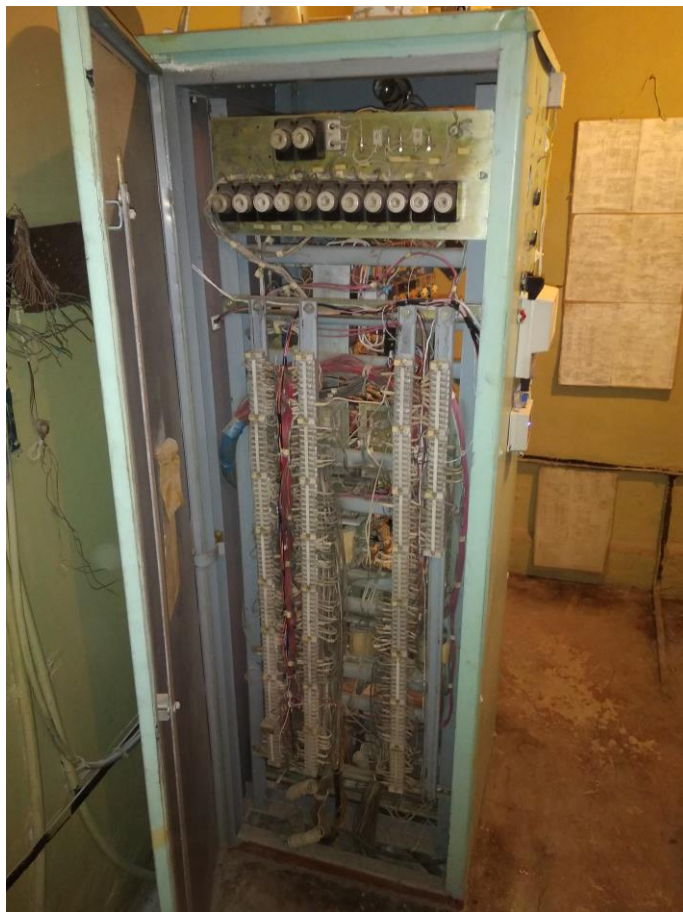
Рисунок 5– Шкаф управления
