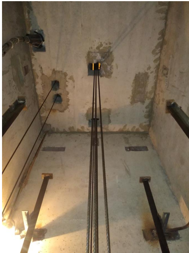
Рисунок 3 – Плита перекрытия шахты
