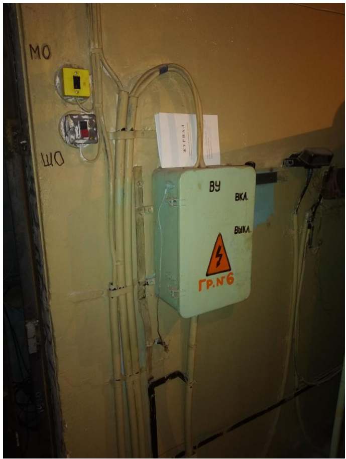
Рисунок 7 – Вводное устройство
