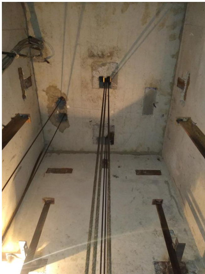
Рисунок 3 – Плита перекрытия шахты
