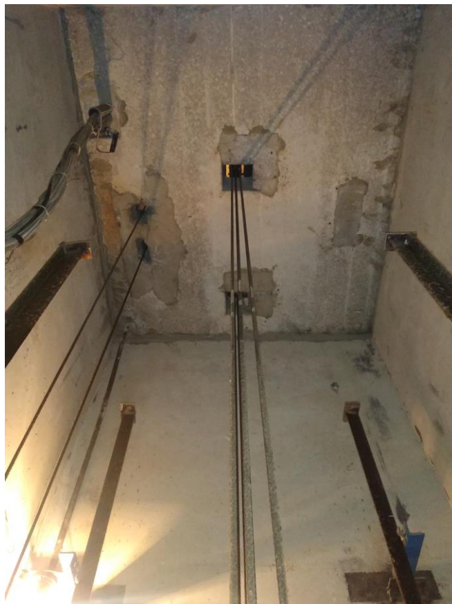
Рисунок 3 – Плита перекрытия шахты
