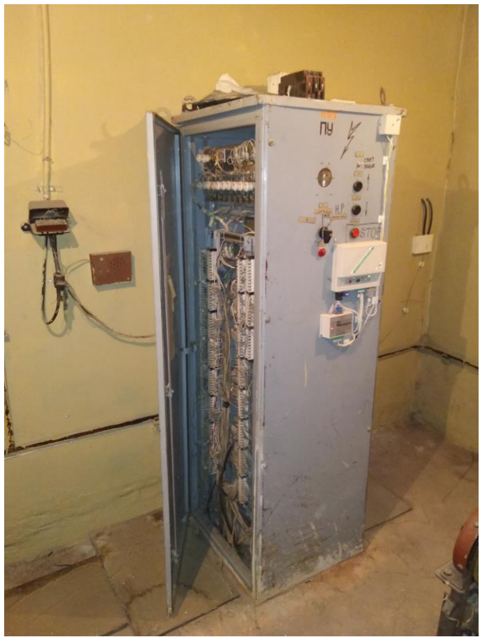
Рисунок 5– Шкаф управления
