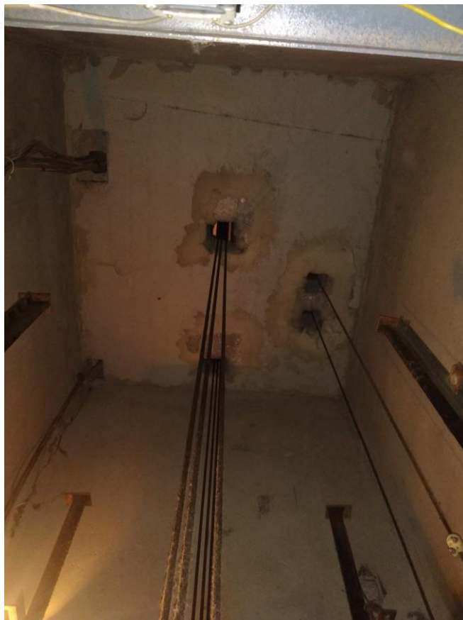
Рисунок 3 – Плита перекрытия шахты
