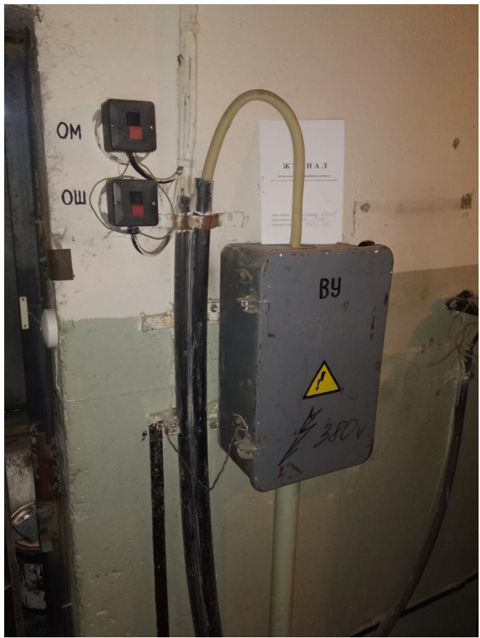
Рисунок 7 – Вводное устройство
