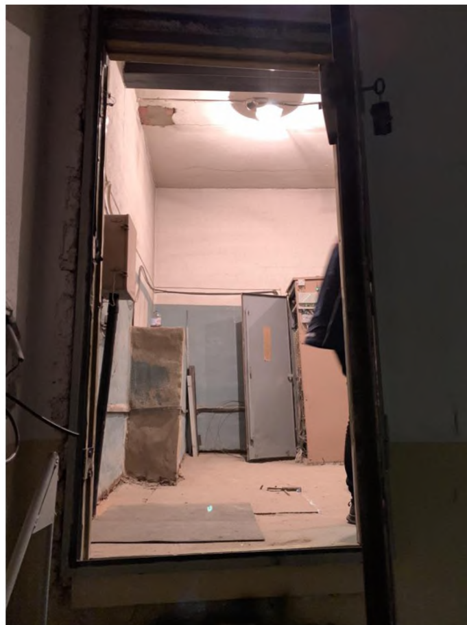
Рисунок 4 – Вход в машинное помещение
