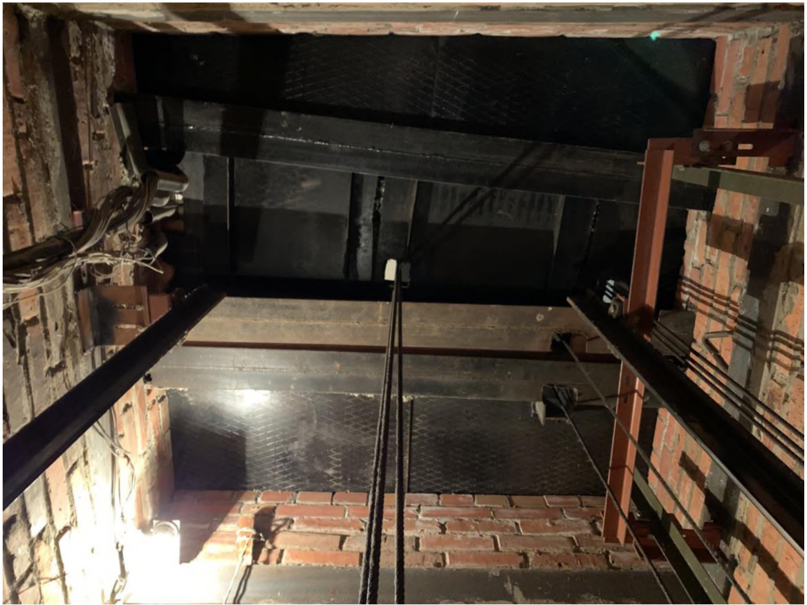
Рисунок 3 – Плита перекрытия шахты
