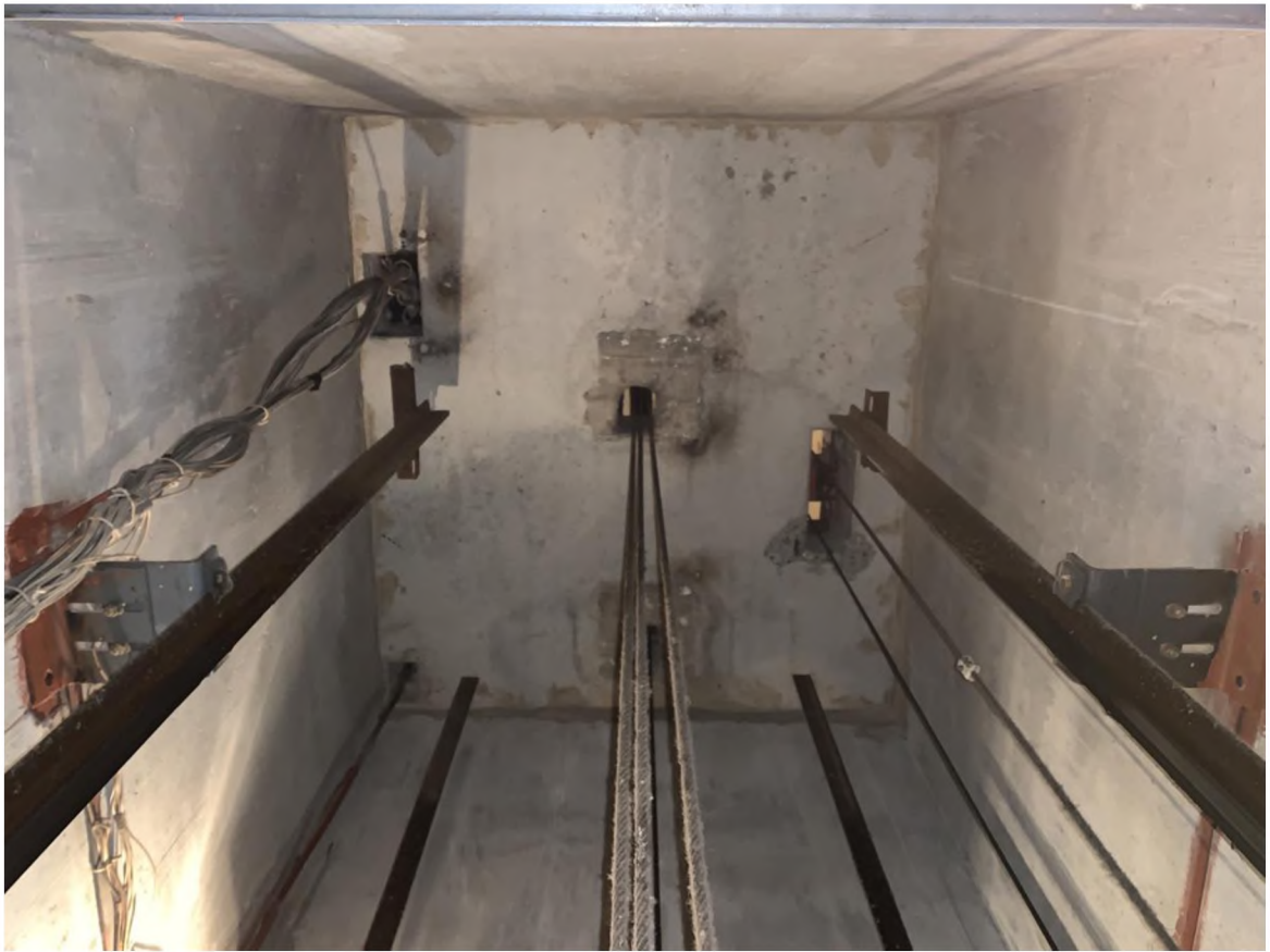
Рисунок 3 – Плита перекрытия шахты
