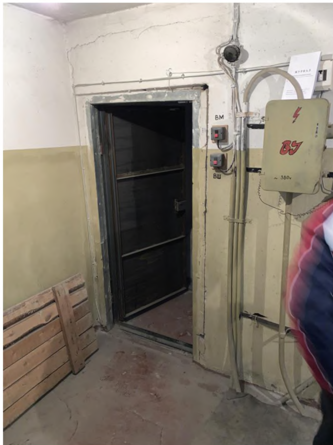
Рисунок 7 – Вводное устройство
