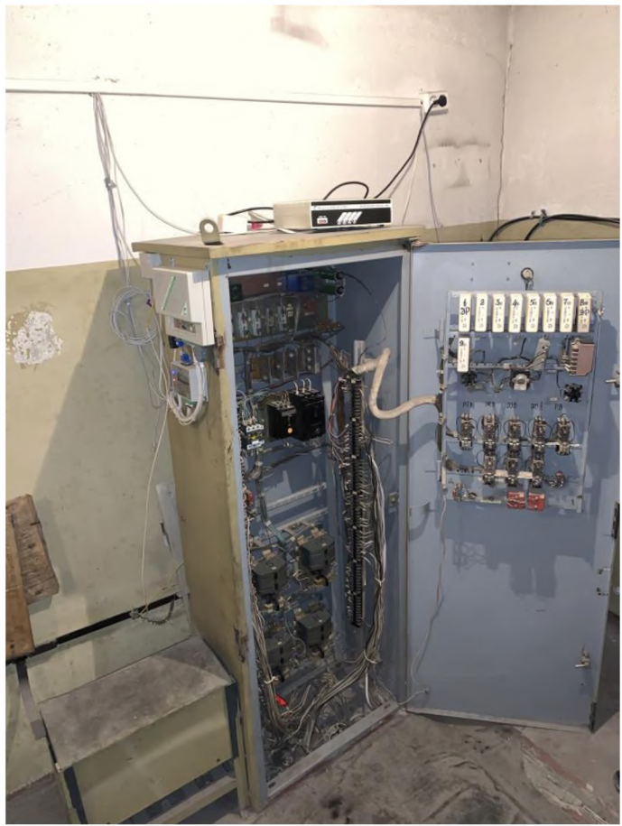
Рисунок 5– Шкаф управления
