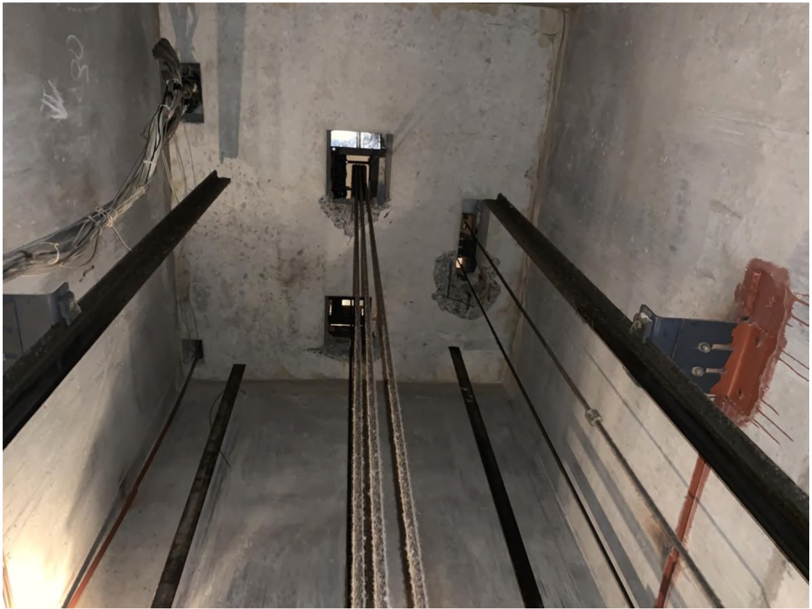
Рисунок 3 – Плита перекрытия шахты
