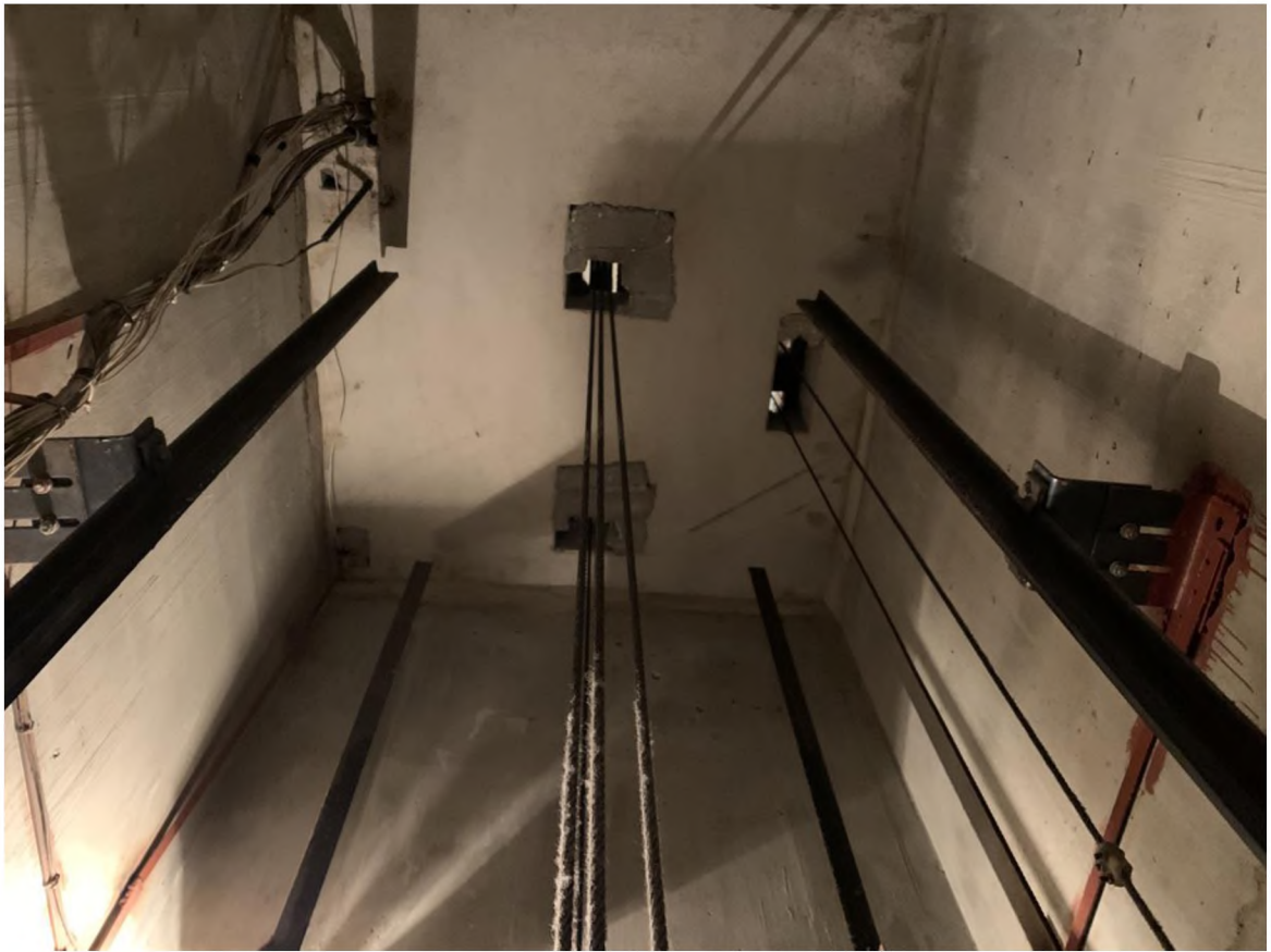
Рисунок 3 – Плита перекрытия шахты
