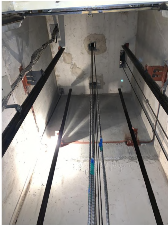
Рисунок 3 – Плита перекрытия шахты
