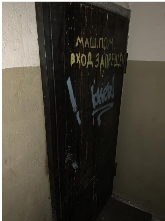
Рисунок 4 – Вход в машинное помещение
