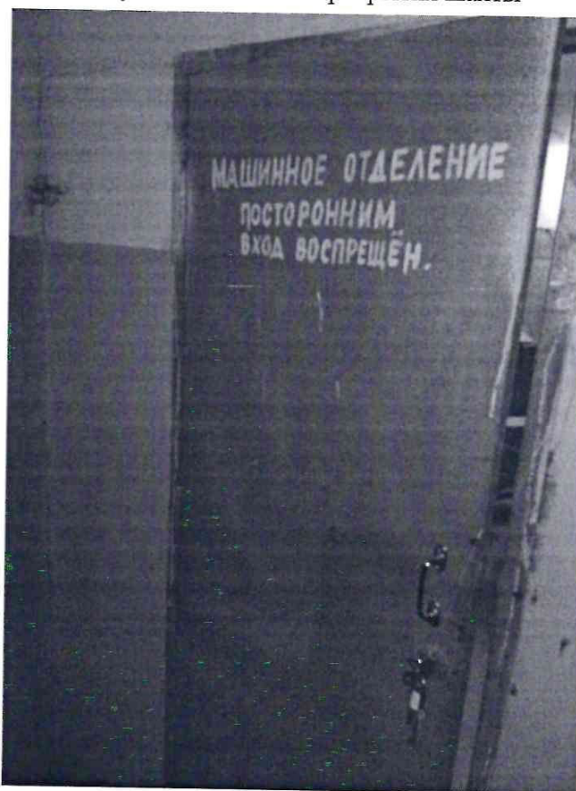
Рисунок 4 – Вход в машинное помещение
