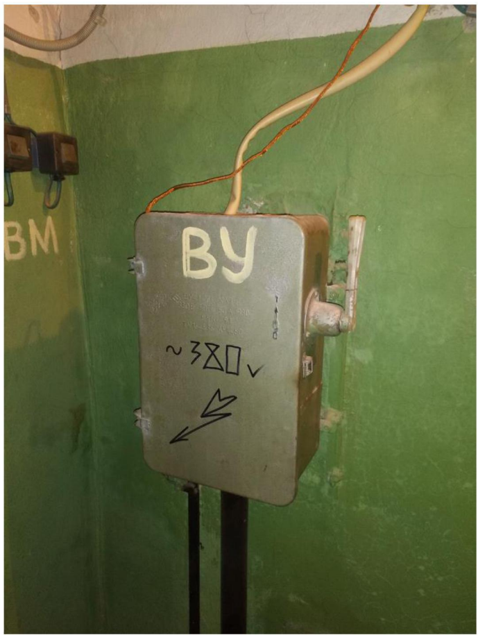
Рисунок 7 – Вводное устройство
