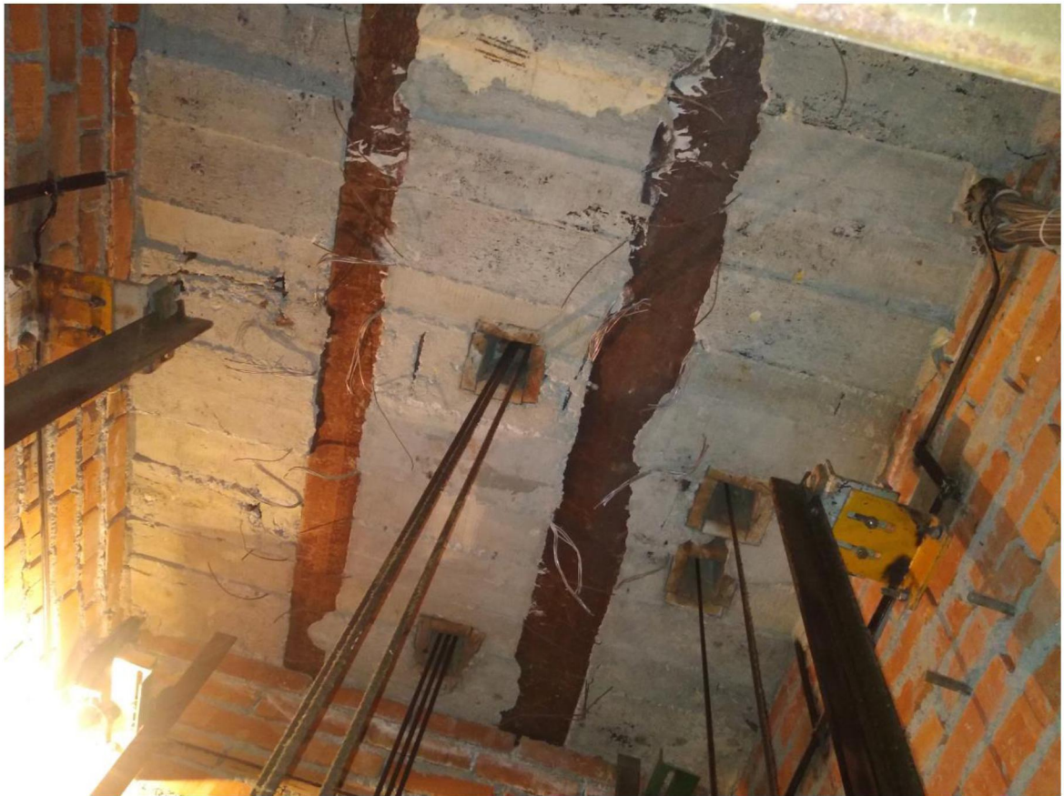
Рисунок 3 – Плита перекрытия шахты
